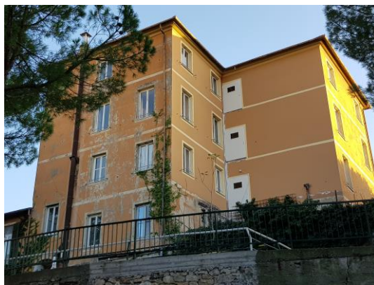
Figura 8.1 - Particolare della muratura esterna
