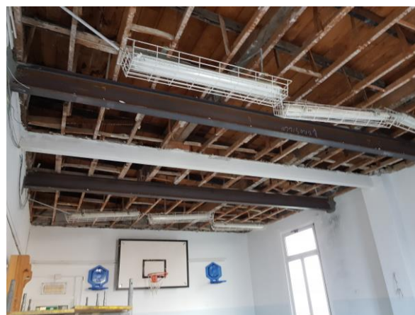
Figura 4.2 - Particolare dell'intradosso della copertura della palestra con struttura in legno
