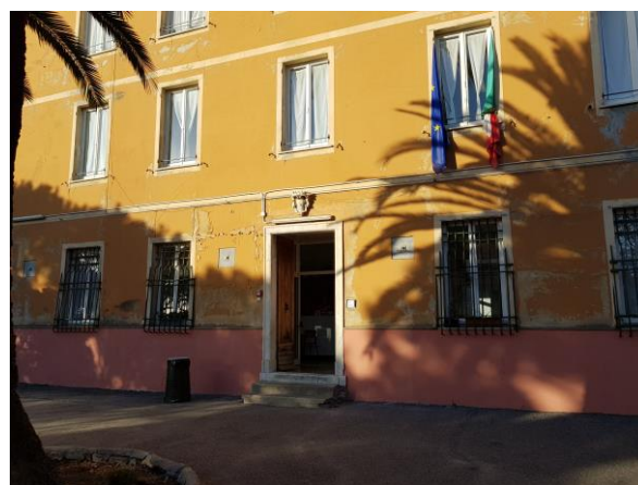
Figura 4.1 - Particolare della muratura esterna portante in prossimità dell'ingresso
